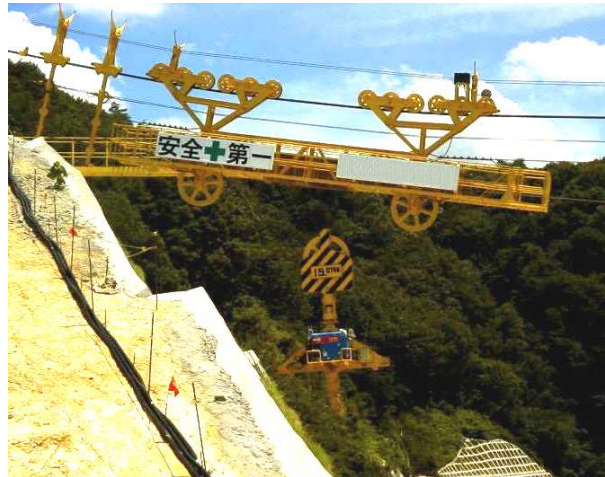
ケーブルクレーン
